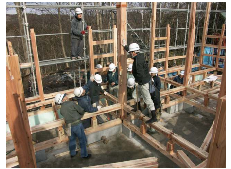
大黒柱建て方、柱脚には足固めが付く
